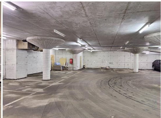
Kuva 28. (vas.) Arkisto kellarikerroksessa K1. Kuva 29. (oik.) Pysäköintitilat kellarissa K2. Sienimäiset pilarit toimivat tilan kantavana rakenteena.
