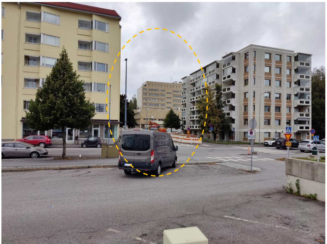
Kuva 43. Porrassalmenkatu 29 kuvattuna rautatieaseman suunnalta idästä. Rakennus näkyy eri-ikäisten kerrostalojen välistä. Kohde esitetty keltaisella katkoviivalla.
